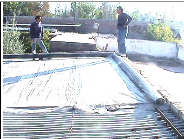
Vista parcial del colector en su etapa de construcción
